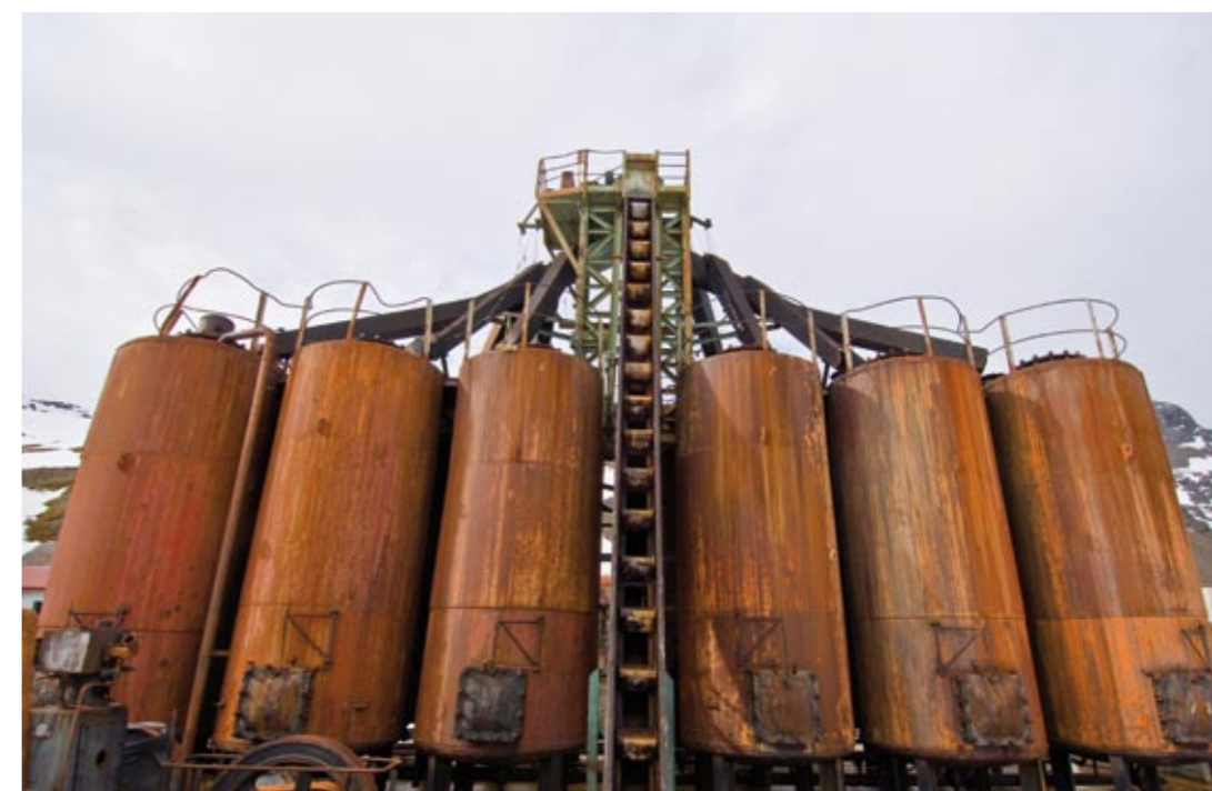
▼ Ook de kookketels zijn met een dikke laag roest bedekt.
